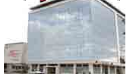
Nova zgrada Societe Generale banke Montenegro New building of Societe Generale banka Montenegro
